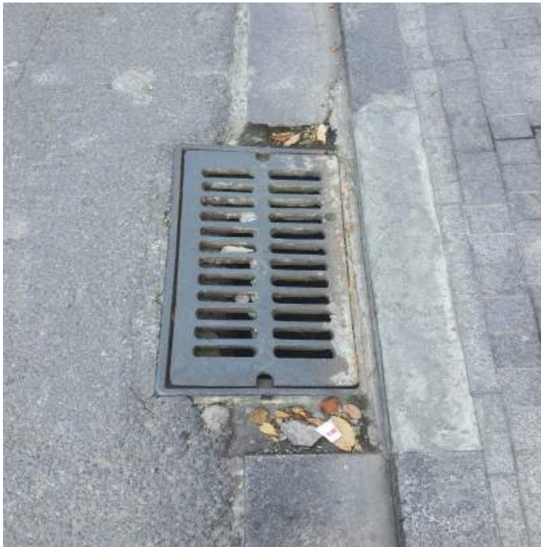
Hình 6. Hình ảnh hố ga thu nước mưa chảy tràn xung quanh cơ sở
