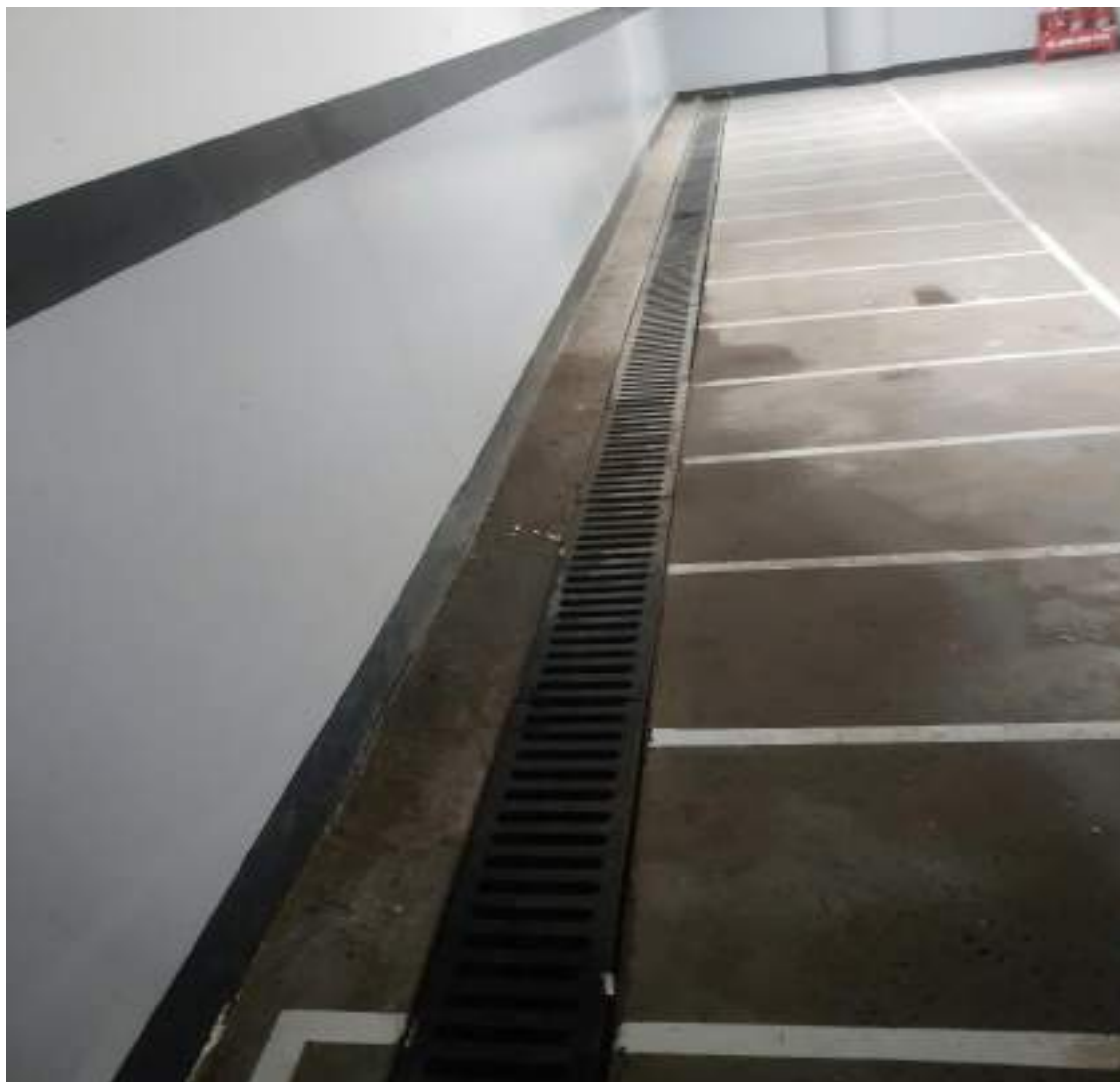
Hình 4. Hình ảnh rãnh thu nước tầng hầm của cơ sở
