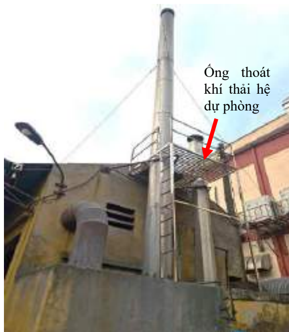
Hình ảnh lò hơi dự phòng và thiết bị xử lý dự phòng
