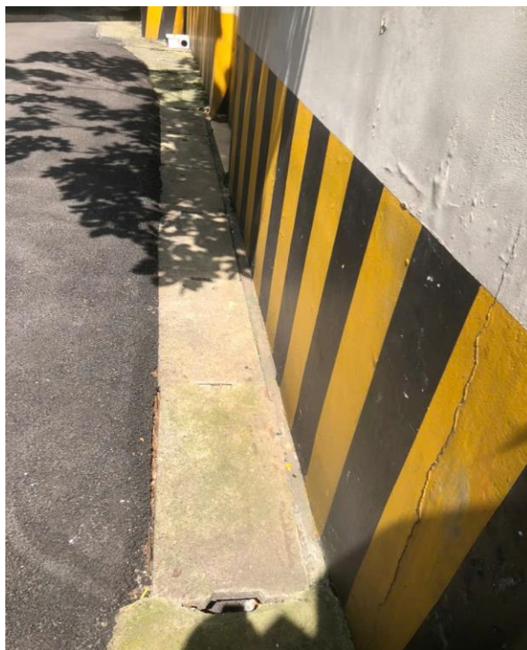
Mương thoát nước mưa bề mặt
