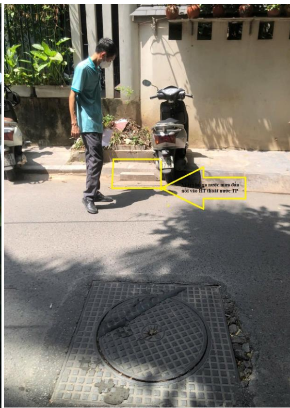
Vị trí xả kiệt nước bể bơi
