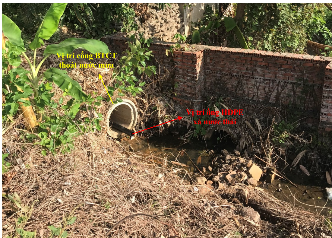
Hình 3.8-Hình ảnh điểm xả nước thải sinh hoạt của cơ sở
