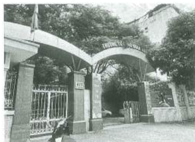
Hình 1-3: Hình ảnh hiện trạng dự án
