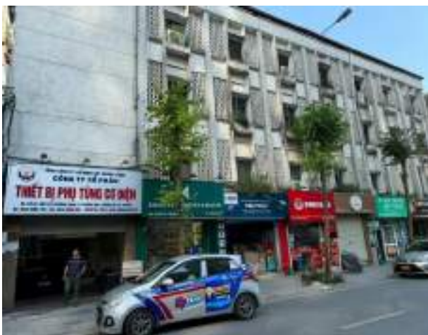
Công vào, dãy nhà 4 tầng
