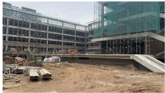
Ảnh 2. Bên trong công trường đang thi công
