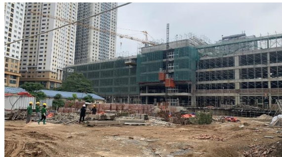
Ảnh 4. Công trường thi công
