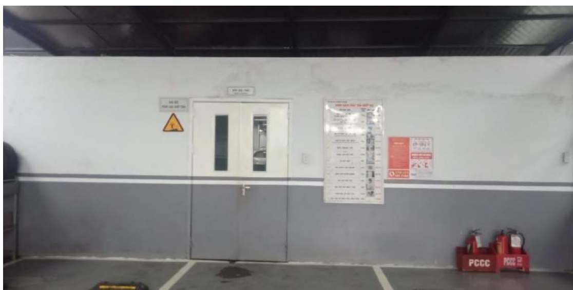
Hình 3.10. Thiết bị lưu giữ và kho CTNH tại cơ sở
