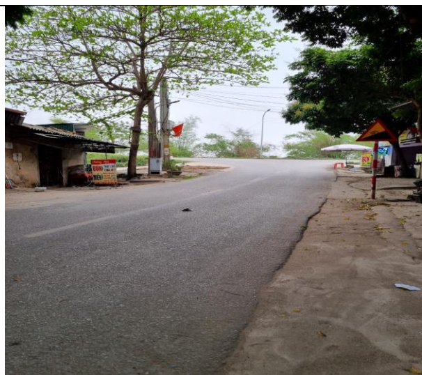
Đoạn cuối tuyến cải tạo giao với đê Vân Cốc
