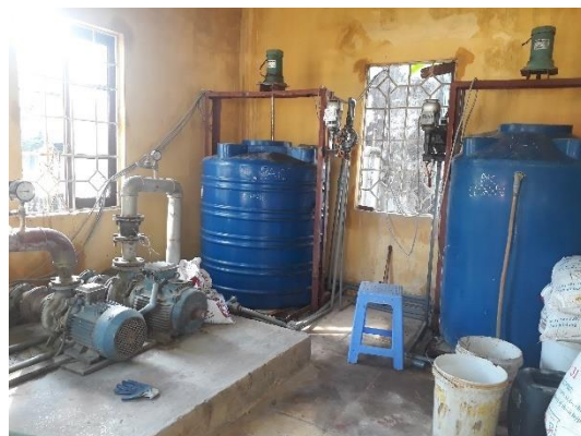
Phòng đặt máy bơm hóa chất, bơm đẩy nước của trạm xử lý nước dưới đất
