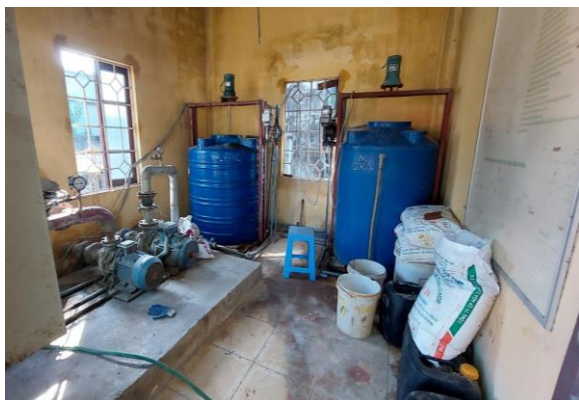
Phòng đặt máy bơm hóa chất, bơm đẩy nước của trạm xử lý nước dưới đất
