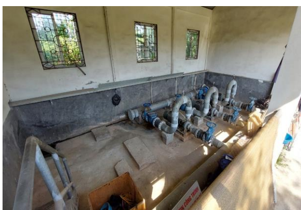
Phòng đặt máy bơm của trạm xử lý nước mặt
