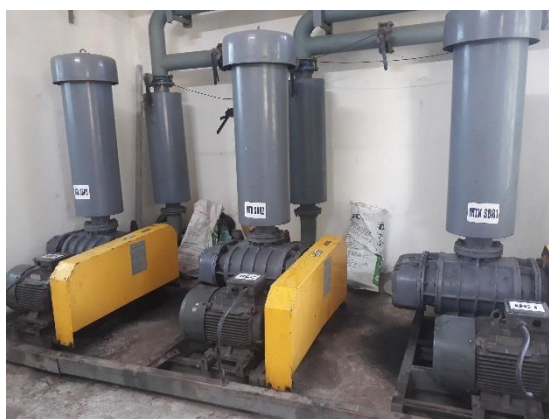
Phòng đặt máy bơm thổi khí của trạm xử lý nước thải
