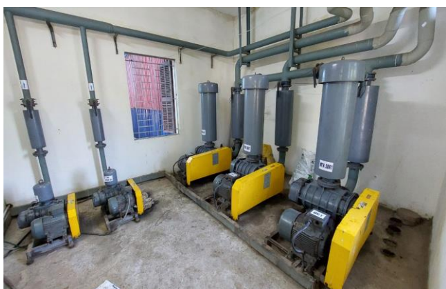
Phòng đặt máy bơm thổi khí của trạm xử lý nước thải
