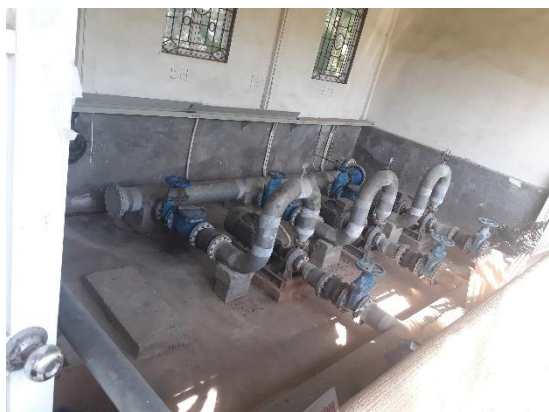
Phòng đặt máy bơm của trạm xử lý nước mặt
