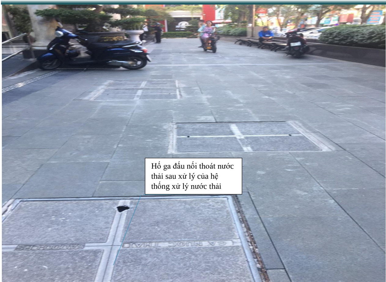
Hố ga đầu nối thoát nước thải của Cơ sở với hệ thống thoát nước của thành phố
