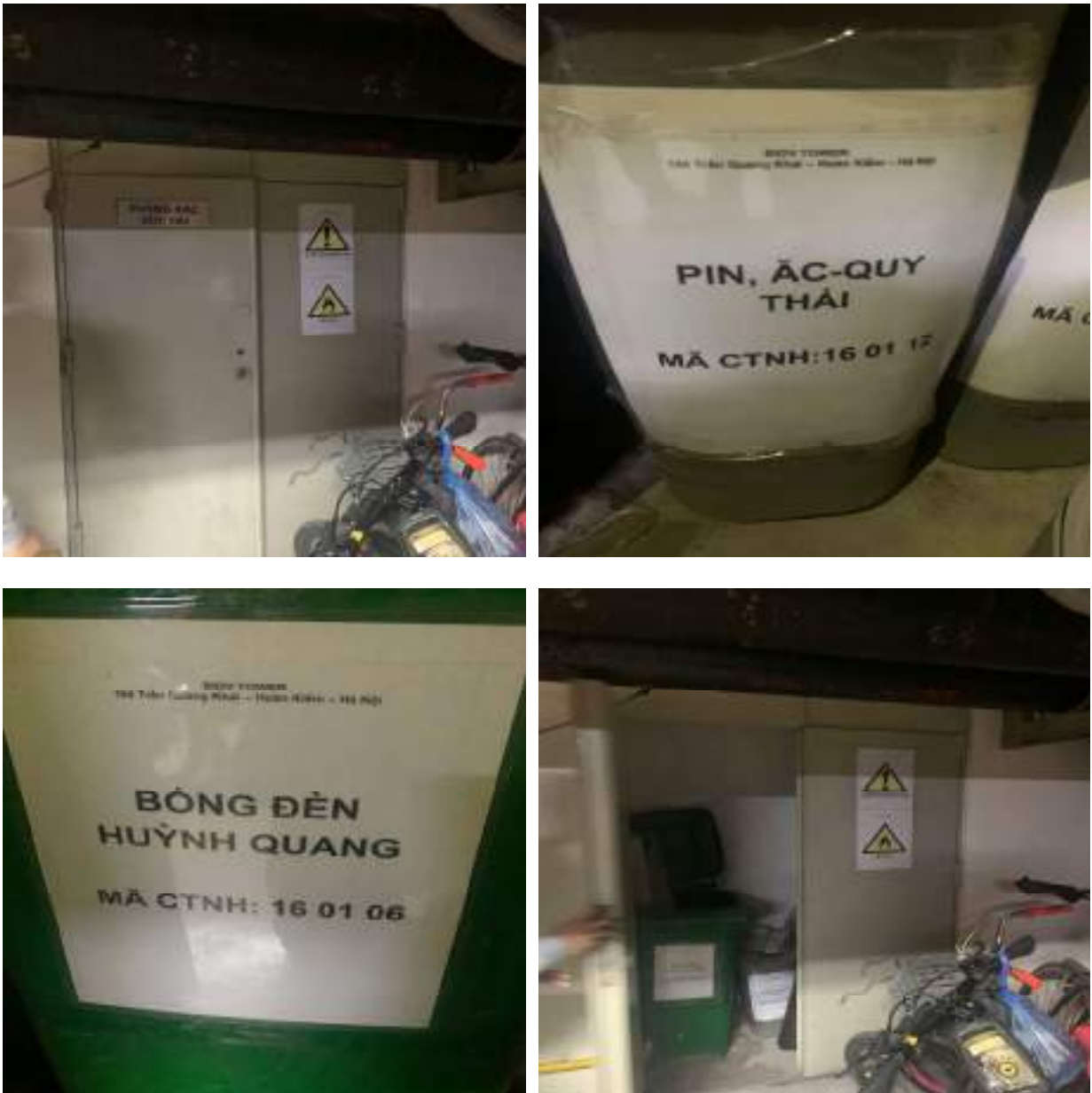
Hình 3. 11. Kho chứa chất thải nguy hại tại cơ sở
