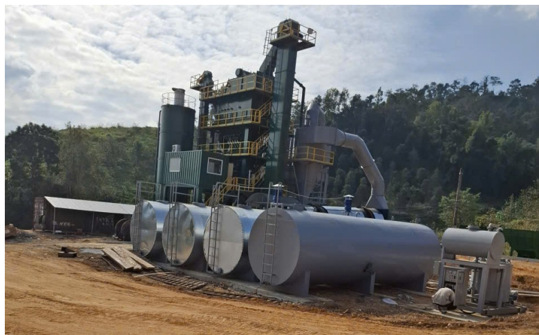
Hình I-11. Hệ thống nồi nấu dầu, nhựa
