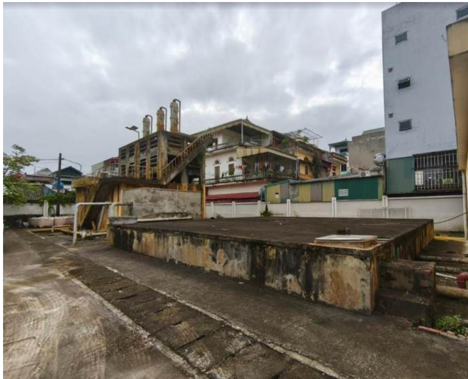
Hình 1-5. Trạm cấp nước sạch 320 m 3 /ngày sử dụng nước giếng khoan của Bệnh viện
