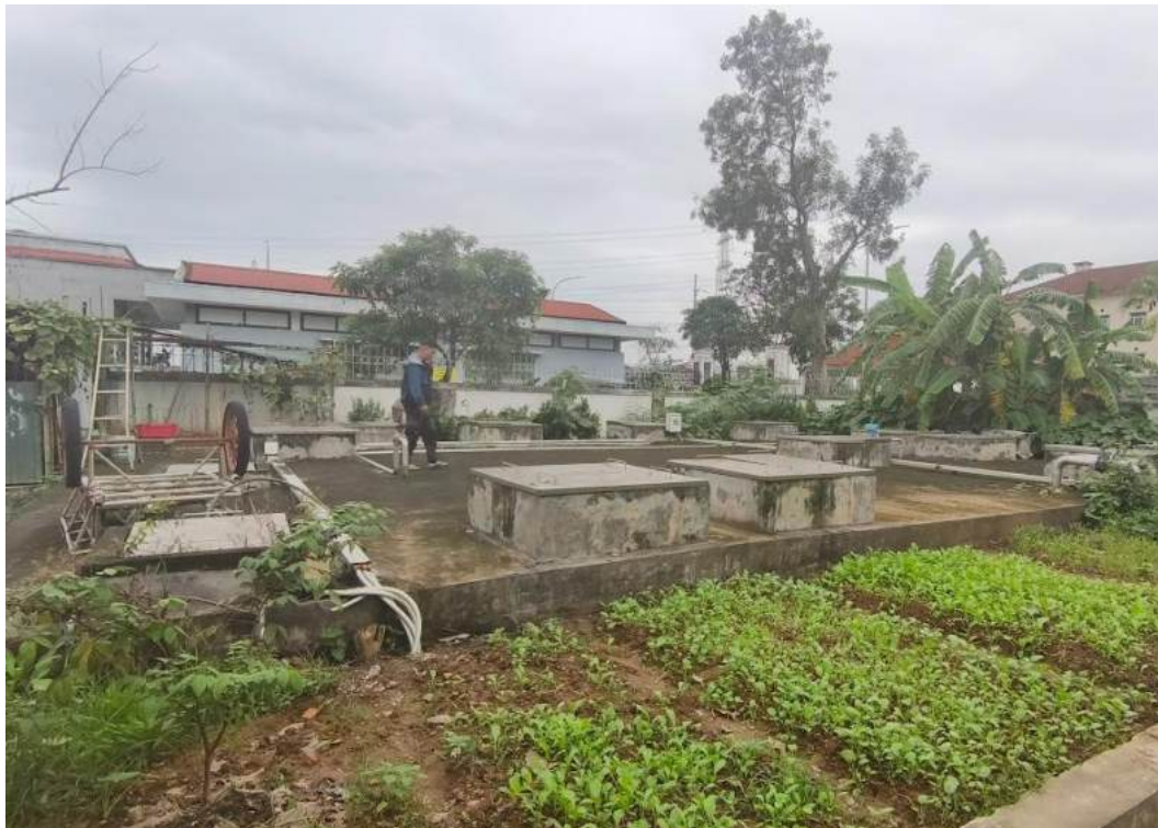
Hình 3-6. Hệ thống XLNT tập trung công suất 400 m 3 /ngày đêm của cơ sở
