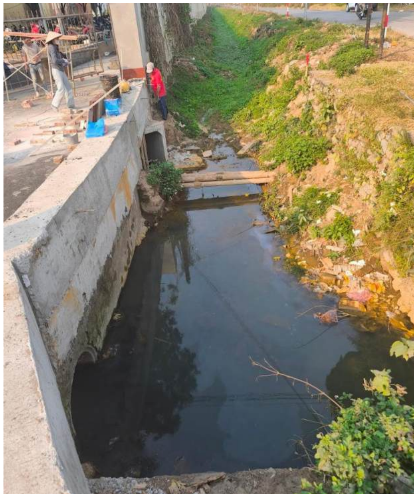
Hình 3-2. Vị trí xả nước mưa ra kênh tiêu Bệnh viện Tâm thần – nguồn tiếp nhận nước mưa và nước thải của Bệnh viện
