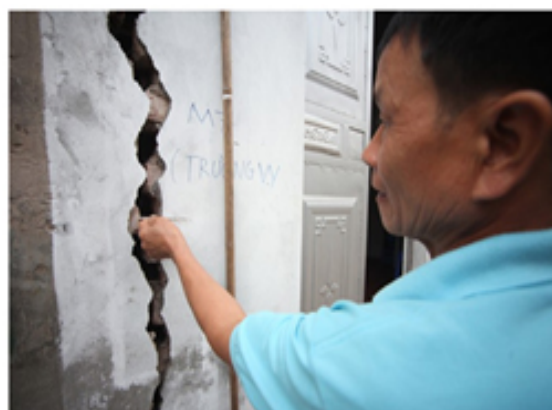
Hình 5.7. Các giếng khoan nước tại xã Thạch Thán, Quốc Oai (bên trái) và vết nứt trên tường nhà gần hố sụt tại xã Yên Sơn.
