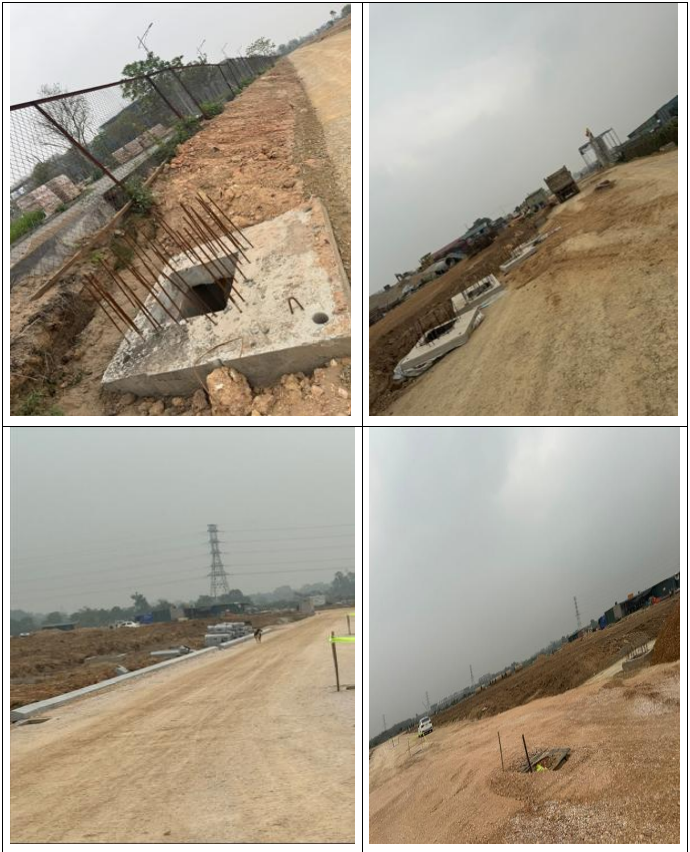
Hình 1. 3. Một số hình ảnh hiện trạng dự án
