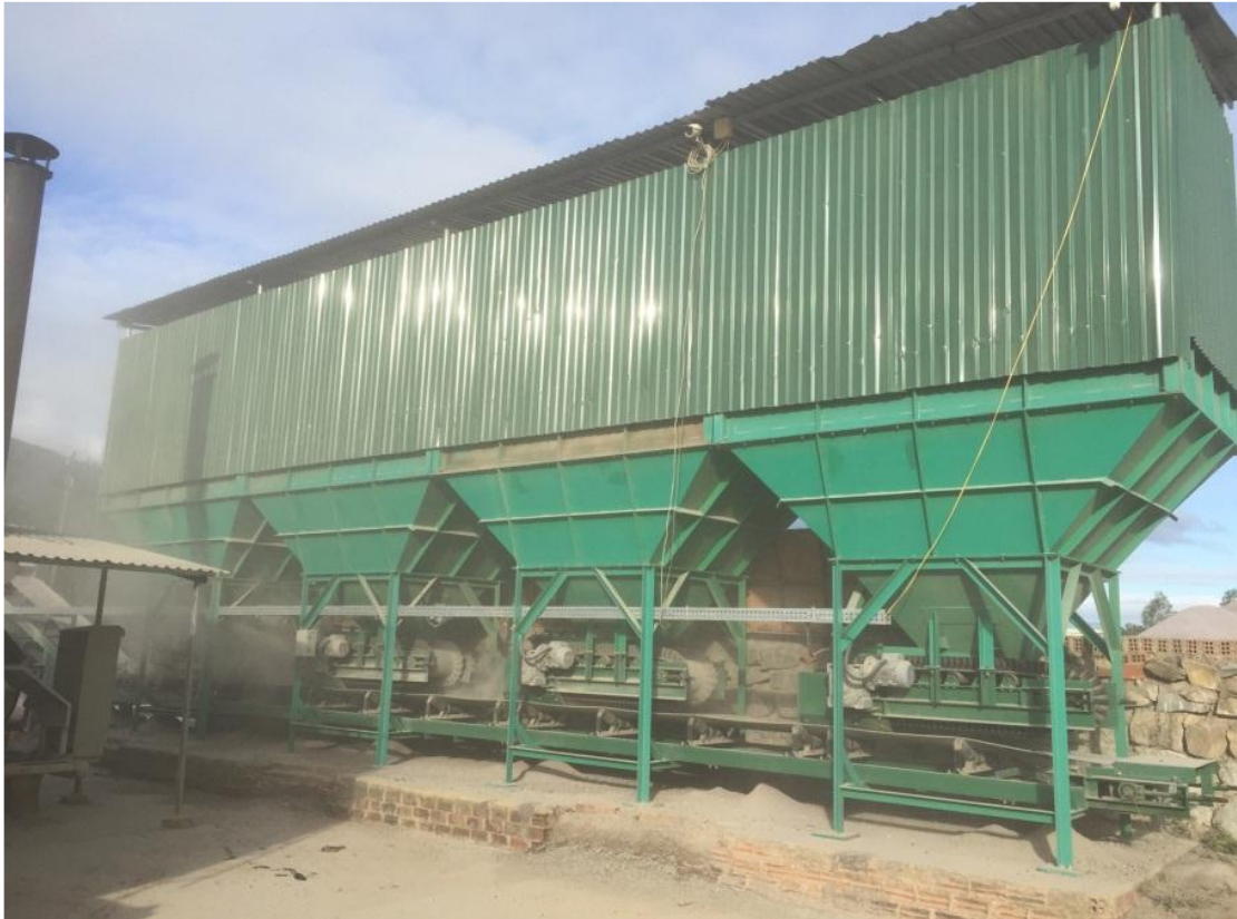
Hình 3. 2. Minh họa tôn che chắn tại khu vực phễu nhập liệu
