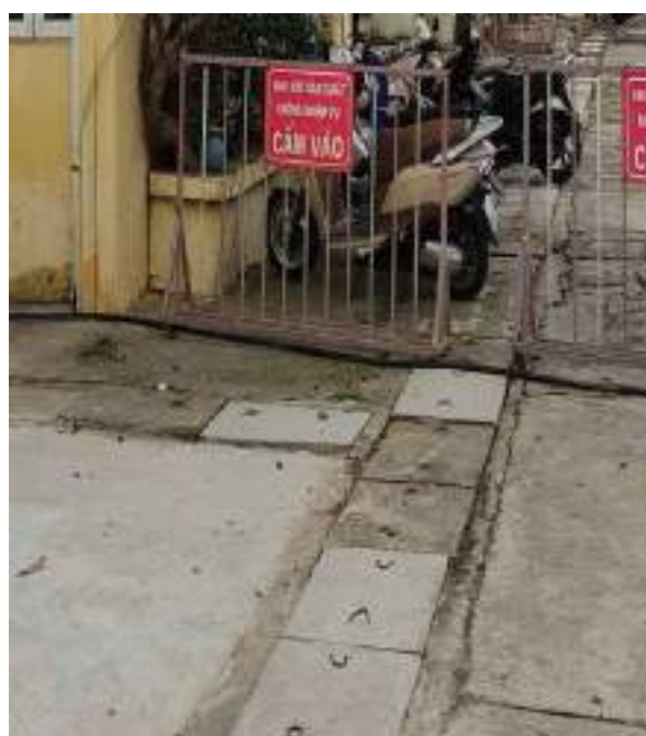
Hình 2.2. Hệ thống thu gom, thoát nước mưa của cơ sở
