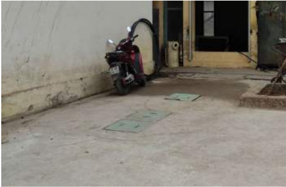
Hình 3.5. Khu vực hệ thống xử lý nước thải sinh hoạt của cơ sở
